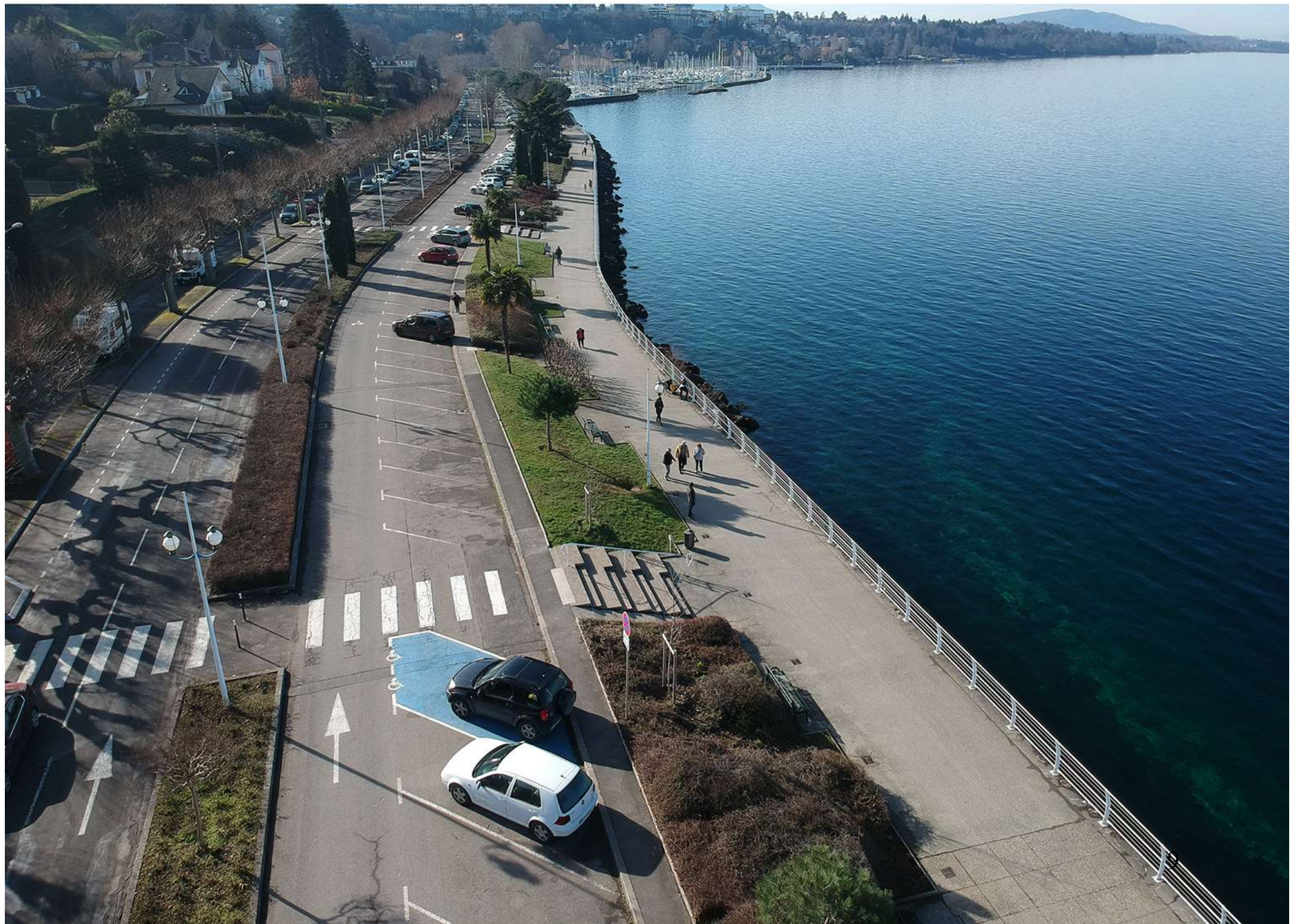
Vue de drone quai de Rives - Etat existant
